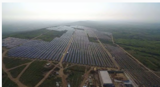
河南禹州50MW光伏电站
