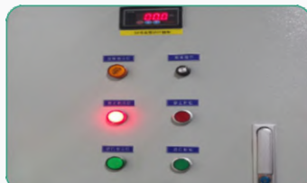
空调水泵变频改造（锂威）
